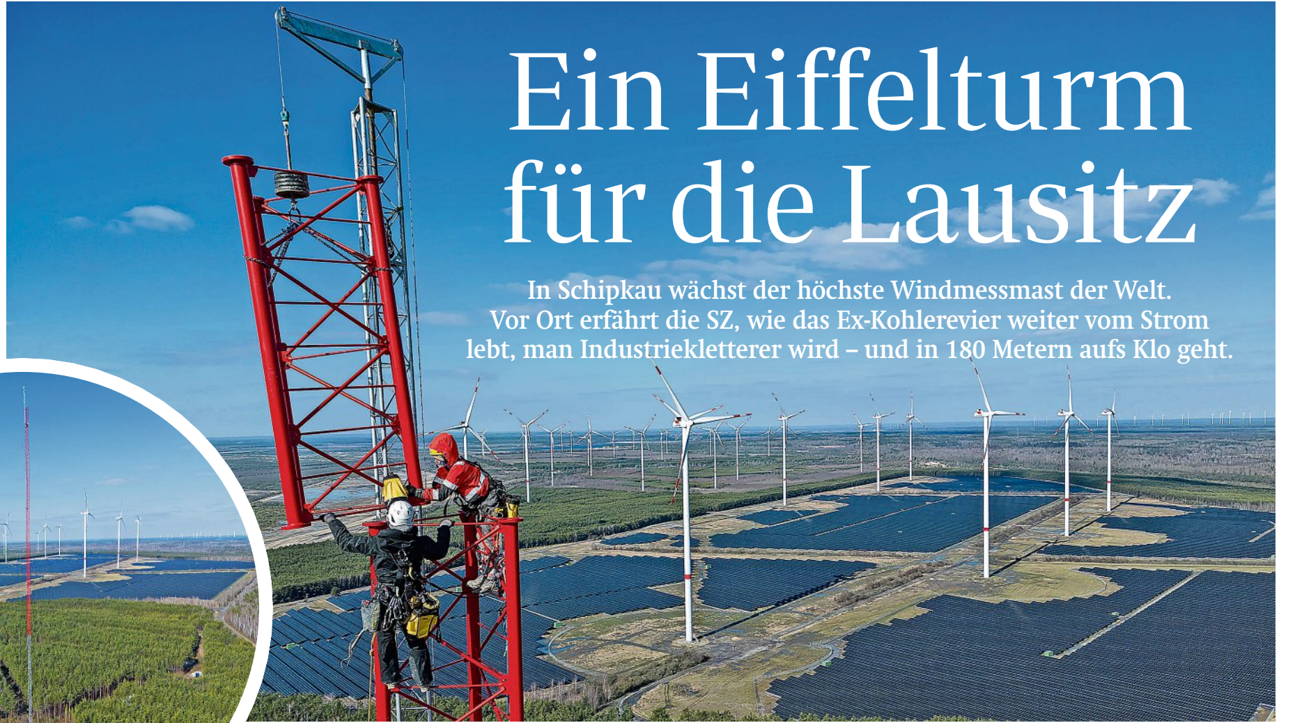
Da wächst was bei Klettwitz: der mit 300 Metern größte Windmessmast. Seine Daten sind Basis für künftige Höhenwindtürme – doppelt so hoch wie die 59 Windräder vor Ort. Tina und Emma befestigen das nächste, fast 500 Kilo schwere, Segment. Die Fotodrohne beobachtet sie.
